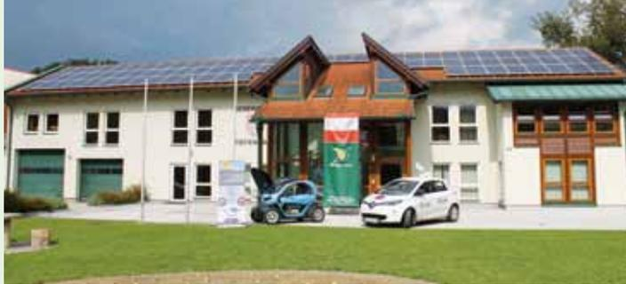
Die Photovoltaik-Beteiligungsgesellschaft der Ökoregion hat auf dem Gemeindeamt Tiefenbach eine weitere Photovoltaik-Anlage realisiert. Insgesamt wurden 114 Kioto-Module und 2 Fronius-Wechselrichter (beide Produkte aus Österreich) auf 188 m<sup>2</sup> Dachfläche verbaut.
