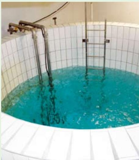
Das Klarwasserbecken in der Aufbereitungsanlage (Fassungsvermögen 16 m<sup>3</sup>) wurde saniert
