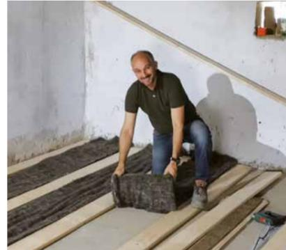
Schafwolle oder Stopfhanf. Zum Boden muss eine dampfdichte Ausführung gewählt werden. Die Böden werden nach dem Verlegen geschliffen und mit Hartöl und Wachs geölt.
